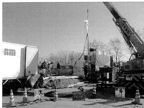
(写真-6) 施工状況
