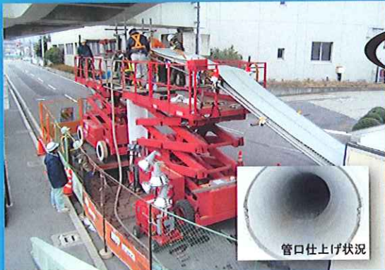
φ500(埋設管) 170m更生工事例
