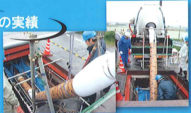
φ300(添架管) 65m更生工事例
