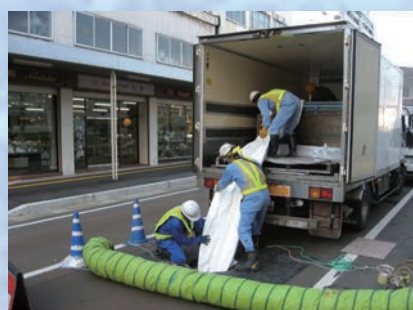
形成(引込み)工法
