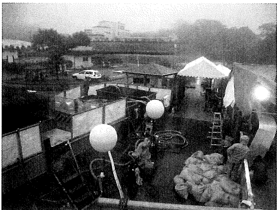
写真-4 現地含浸，反転タワー配置状況
