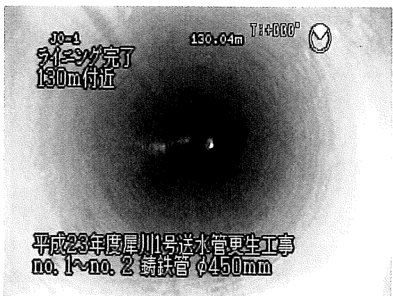
写真-8 更生後管内写真
