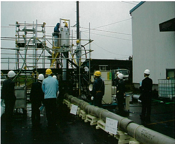
写真－１ 施工性確認状況（反転工法）
