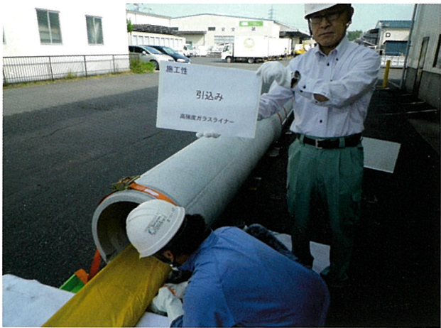
写真-2 施工性確認状況
