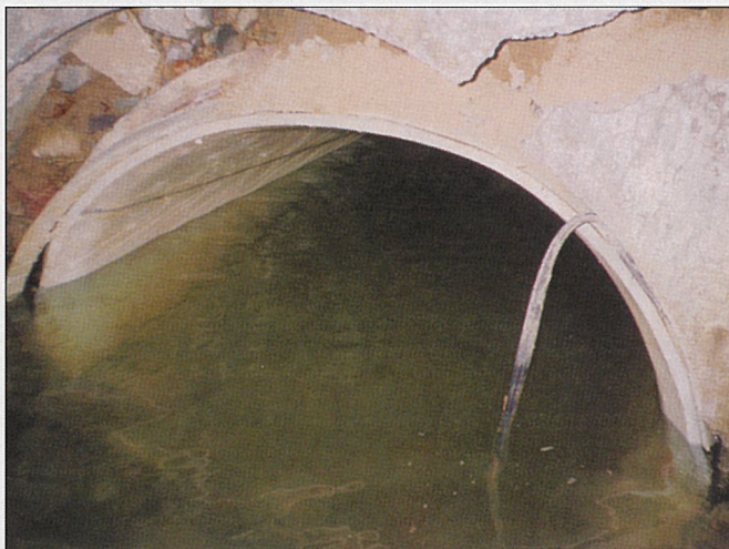
管口状況 異常なし 人孔横移動
