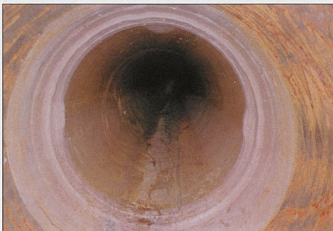
接続部状況 異常なし
