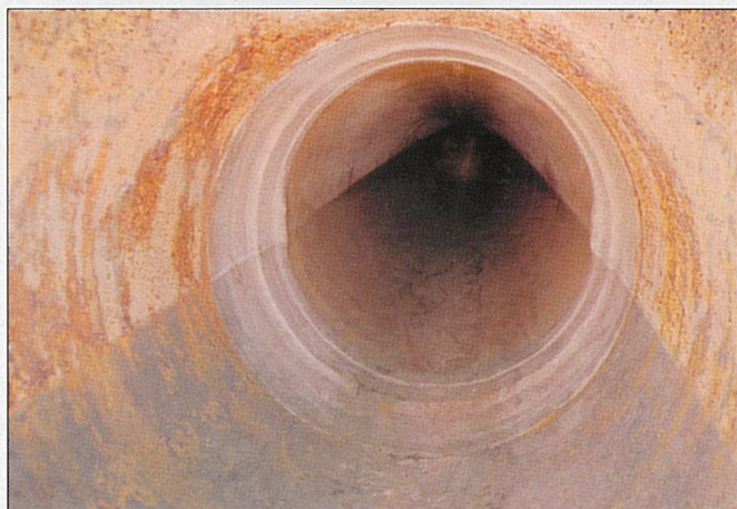
接続部状況 異常なし
