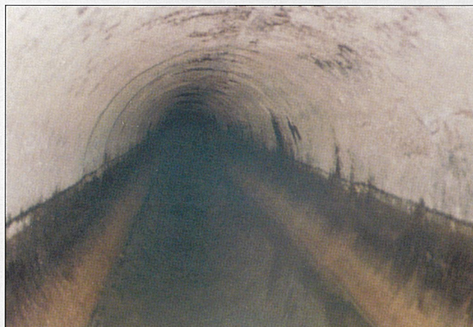
管内状況 異常なし
