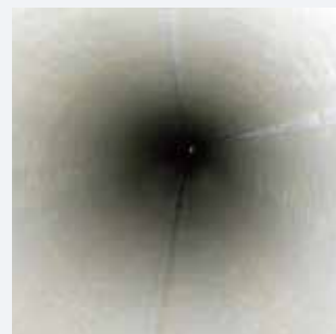
完成（施工後管内）
