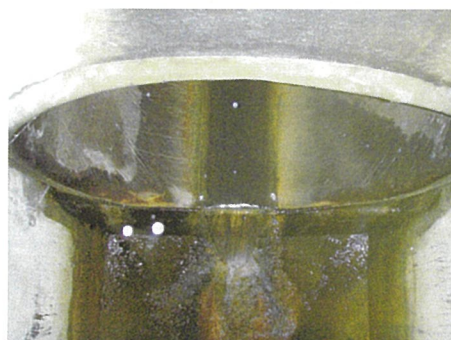
写真-1 管口状況
