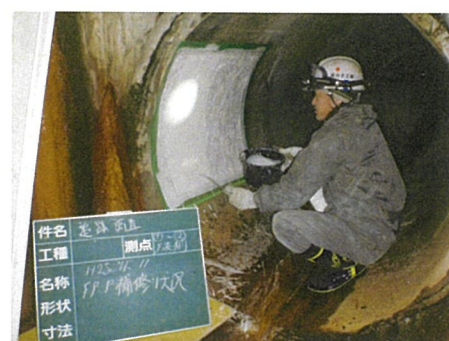
写真-4 FRP補修状況
