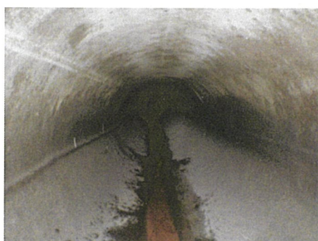
写真-2 管内状況
