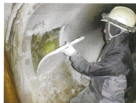
写真-3 供試体採取状況
